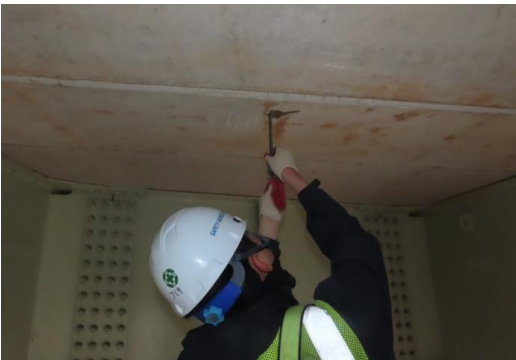
탄산화 깊이 측정 전경
